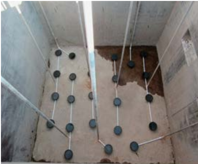
تصویر شماره ۳۲: حوضچه‌های هوادهی در دامپروری صالحی و صفاری (چالتاسیان).
