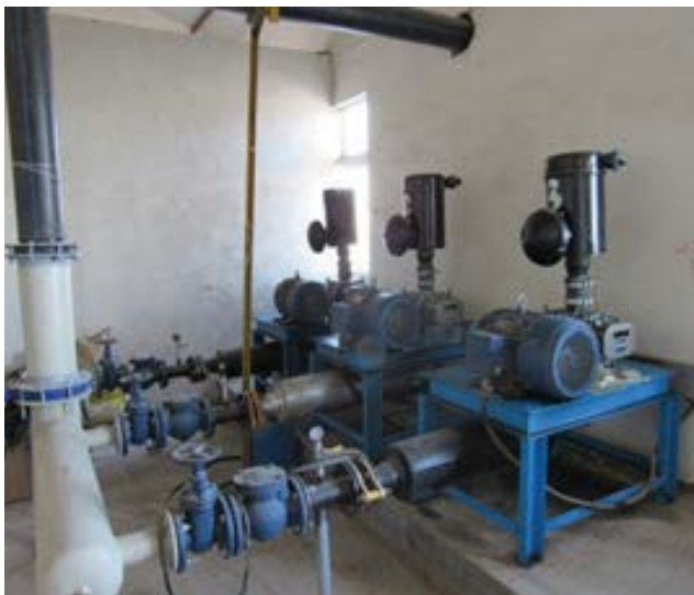
تصویر شماره ۳۳: نمونه بلوئر و دیفیوزر استفاده‌شده در دامپروری صالحی و صفاری (چالتاسیان).
